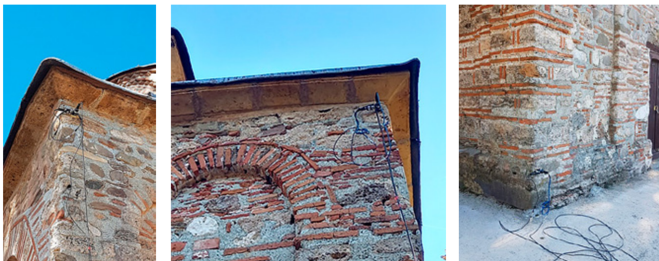
Сл. 6 Позиционирање на акцелерометри на црквата
